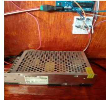
Gambar 6. Pemasangan Power Suplay
