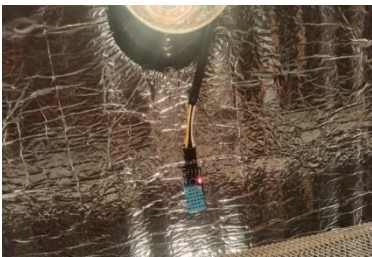
Gambar 10. Pemasangan Sensor DHT11
