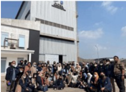
Gambar 3. Pembangkit Listrik Tenaga Sampah
