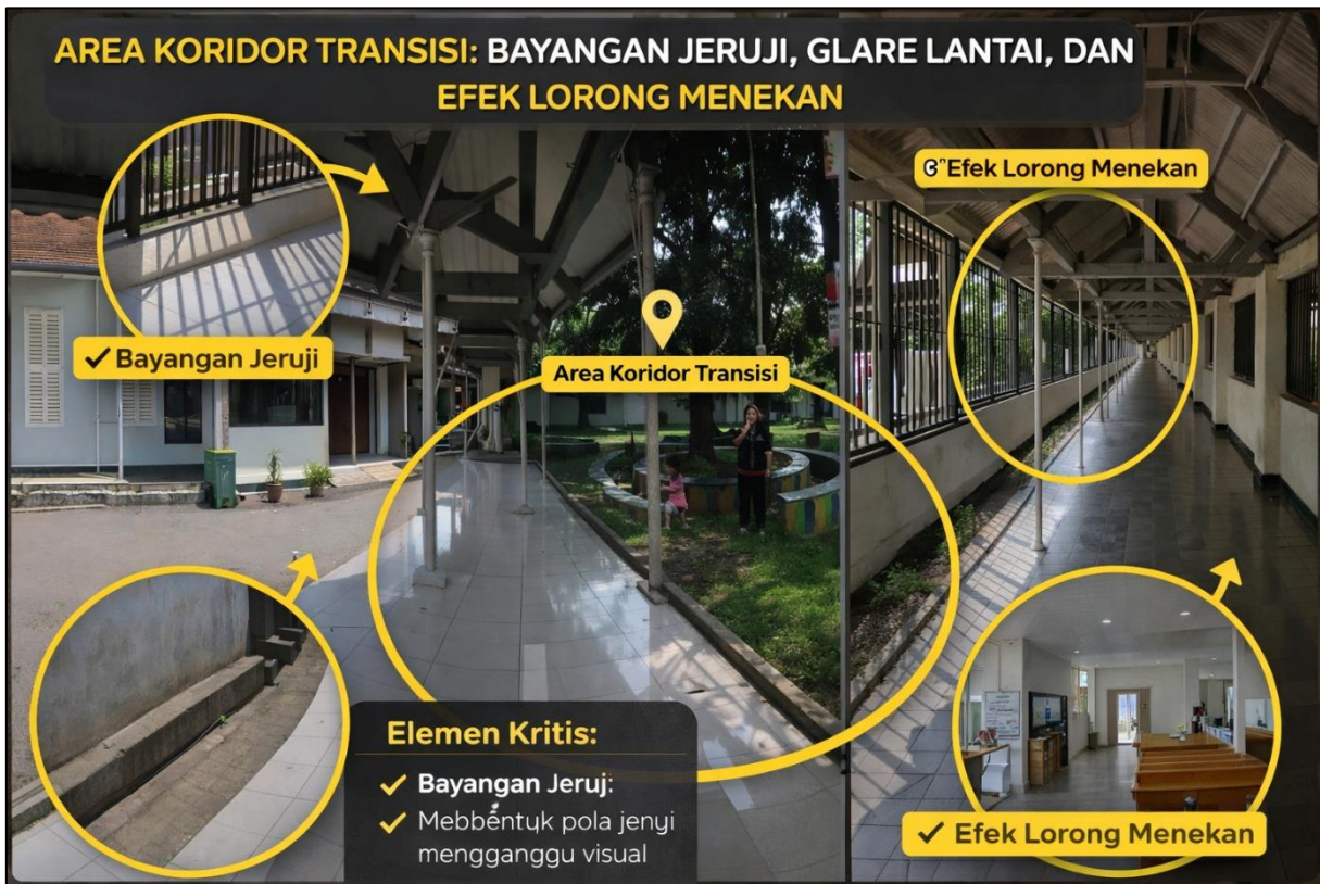
Gambar 4. Koridor transisi: bayangan jeruji, glare lantai, dan efek lorong menekan Sumber: Dokumen pribadi, 2025
