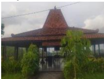
Gambar 8. Atap bangunan sekarang Sumber: Dokumentasi Peneliti, 2026
