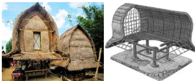
Gambar 1. Tampak Bale Lumbung Desa Sade & Ilustrasi Potongan Bale Lumbung Sumber: http://wisatadilombok.com & https://tinyurl.com/BABII-UB
