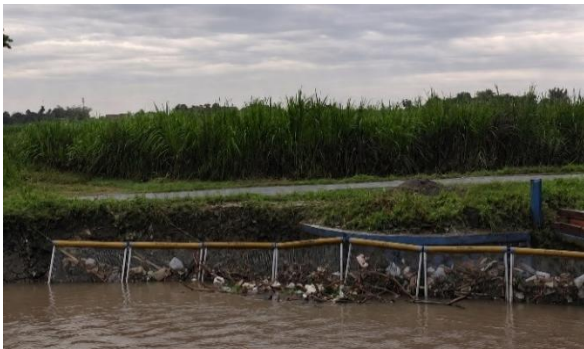
Gambar 5. Kondisi sungai setelah pemasangan river barrier
