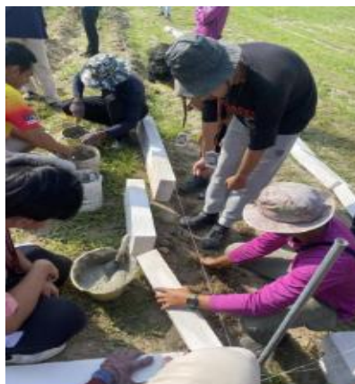
Gambar 8. Praktik pembuatan pondasi lahan pertanian ( plantebox )
