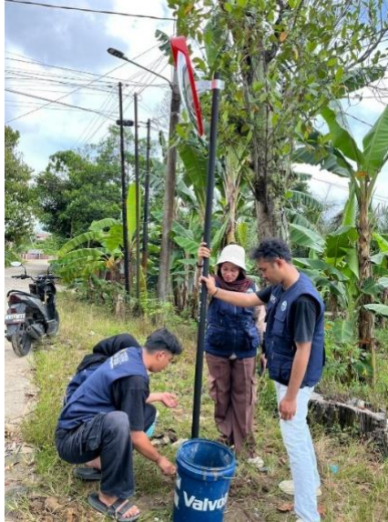
Gambar 2. Pemasangan Kaca Cembung
