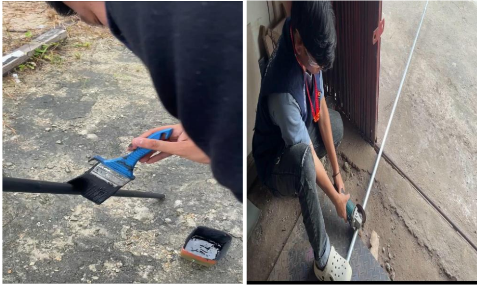
Gambar 3. Proses Pemotongan dan Modifikasi Tiang Pipa Galvanis
