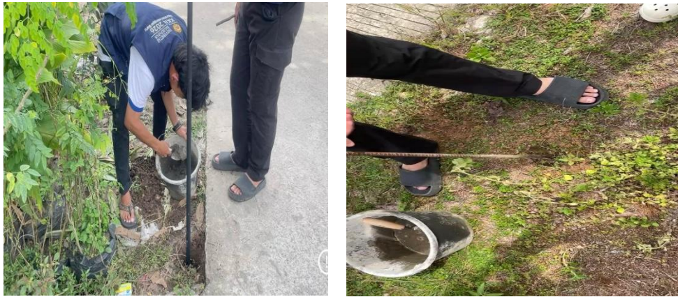
Gambar 5. Proses Pengecoran Fondasi Plang Nama Gang di Lapangan
