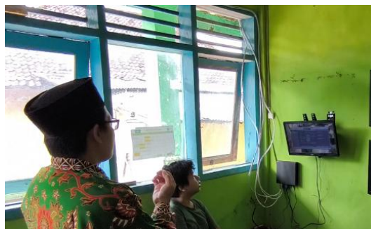
Gambar 6. Proses Pengujian Sistem CCTV di Lokasi Madrasah
