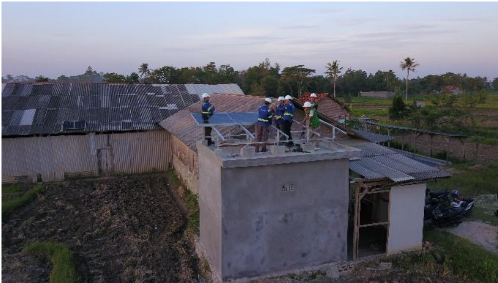
Gambar 3. Proses Pemasangan Modul PLTS
